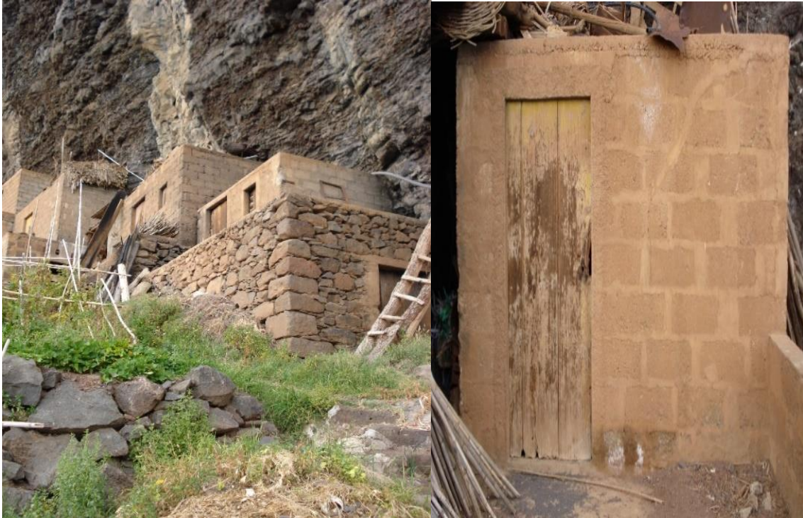
Figura 52 – Edifícios de apoio agrícola, Fajã dos Asnos (Cabo Girão). Fonte: © Associação Insular de Geografia.
