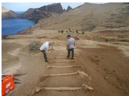
Figura 10-Trabalhos de recuperação do trilho
