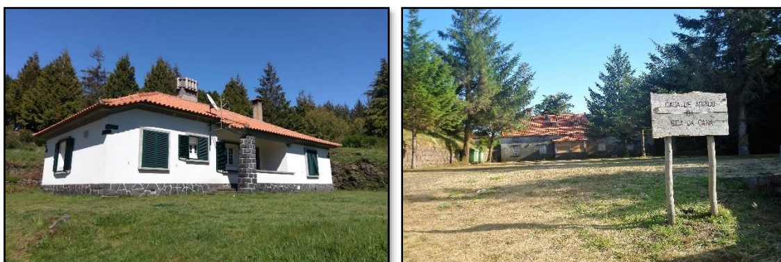
Figura 21 – Posto florestal dos Estanquinhos (esquerda) e Casa de Abrigo da Bica da Cana (direita).
