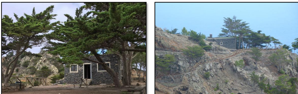
Figura 15 – Casa de abrigo do Pico Branco (Fonte: IFCN, IP-RAM).
