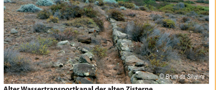
Alter Wassertransportkanal der alten Zisterne
