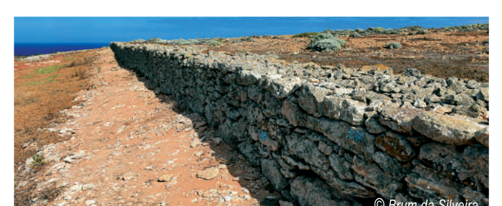
Muro de pedra
